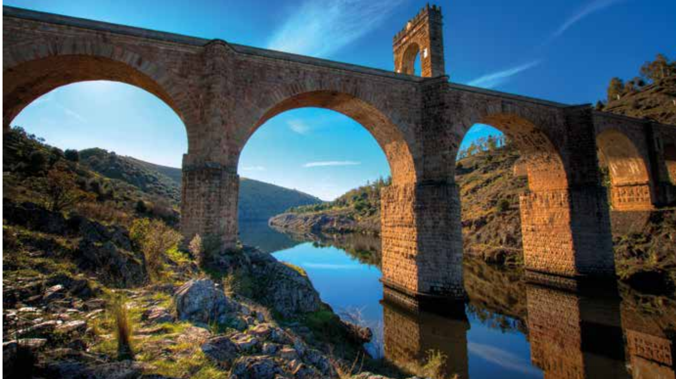
Proyecto Puente de Alcántara Desde abajo
